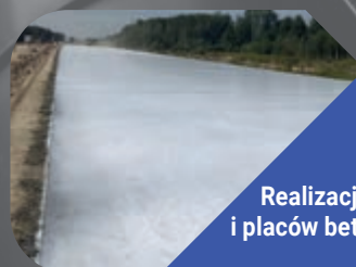
Posadzki przemysłowe i place betonowe
